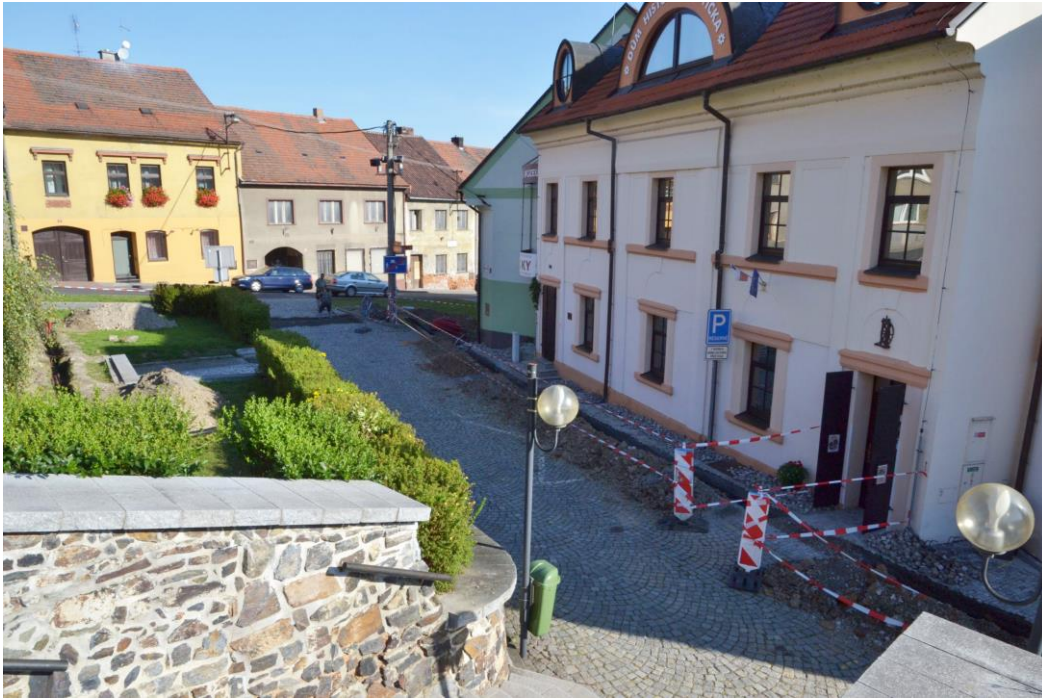
Výkopy k pokládání kabelů před muzeem
