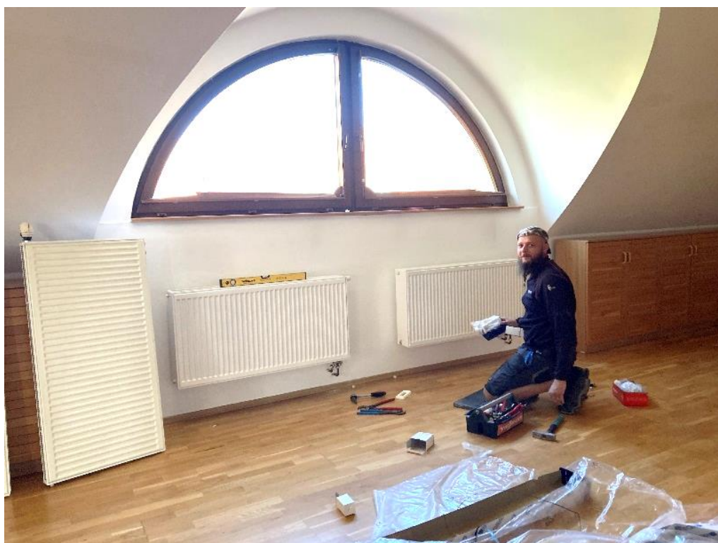
Výměna radiátorů v podkrovním výstavním sále
