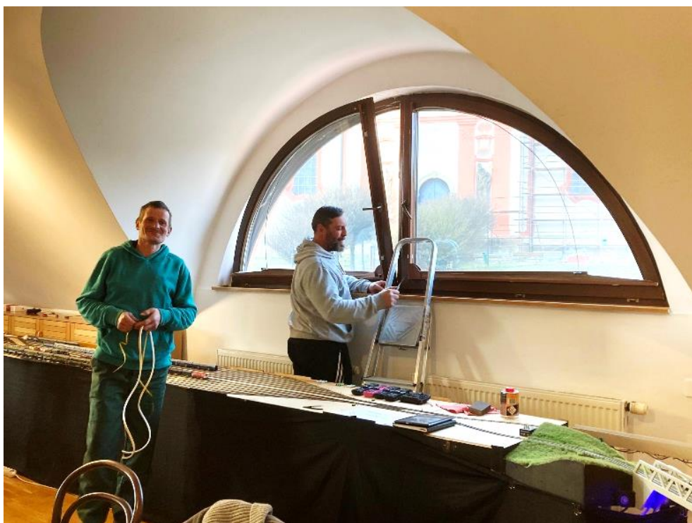
Seřizování oken, doplnění těsnění a oprava ventilaček
